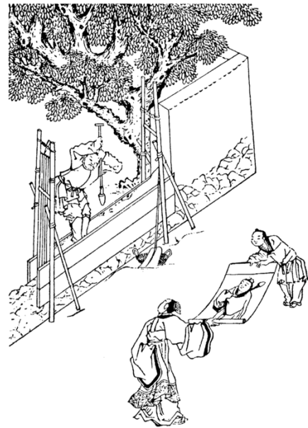
Abbildung 1 Lehmstampfbau im Alten China (Quelle: Lehmbau, Springer Vieweg, 2019)
