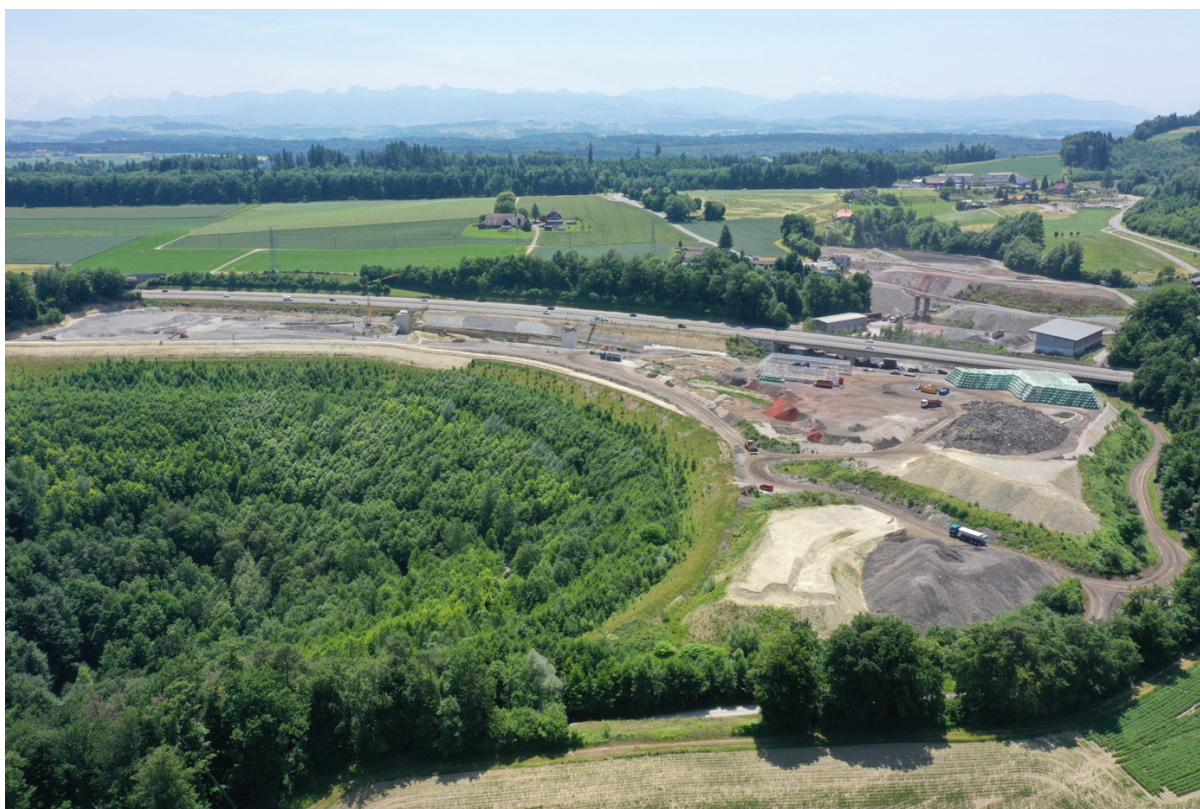
Figure n°37, Décharge de la terre de type E, Berne, source 14 : Berner Zeitung
