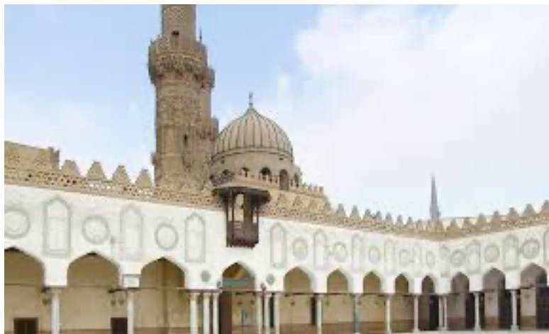
Figure n°4, Mosquée Al-Azhar, source 5 : Egypttoursportal
